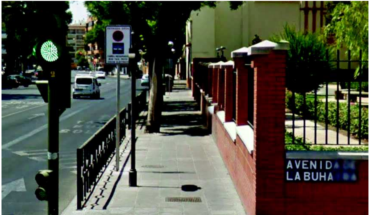
Ilustración 22. Estrecho acerado en la calle Luis Montoto (inferior a 2m) en lo que debería ser un corredor peatonal de nivel ciudad
