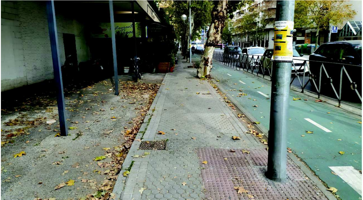
Ilustración 49. Acerado insuficiente en un corredor peatonal (Avenida de la Borbolla)
